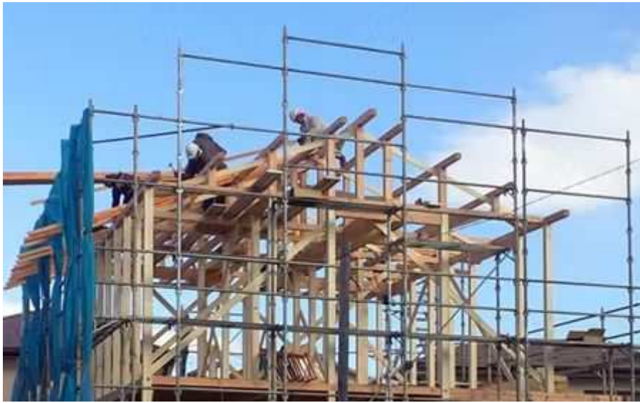
金杉屋（水戸市）は住宅の建設工事も担当する
